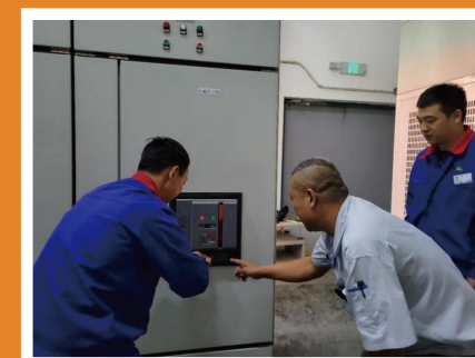
设备部切换调试电源
